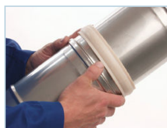
3. Positionner le joint exactement à l'emboîtement.
