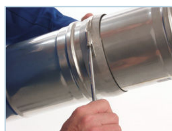
6. Serrer la bride à l'aide d'un tournevis plat.
