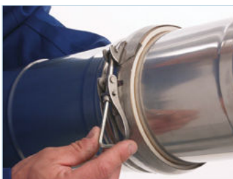
6. Serrer la bride plus fort avec une clé hexagonale.
