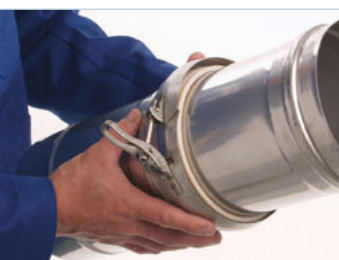
5. Positionner la bride sur le joint blanc et refermer.
