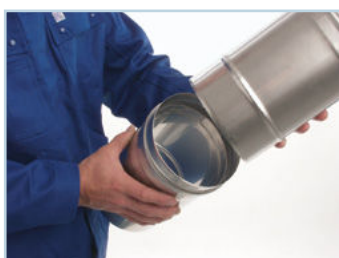
4. Graisser légèrement après la pose du joint.
