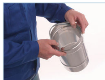
3. ATTENTION, la pose du joint se fait lèvres vers le bas.
