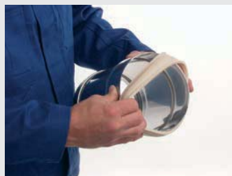
2. Coulisser le joint sur le conduit.
