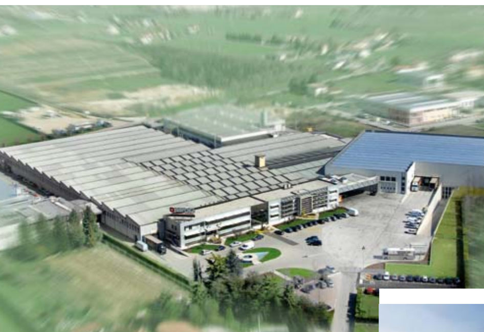
Stabilimento La Nordica Montecchio Precalcino
